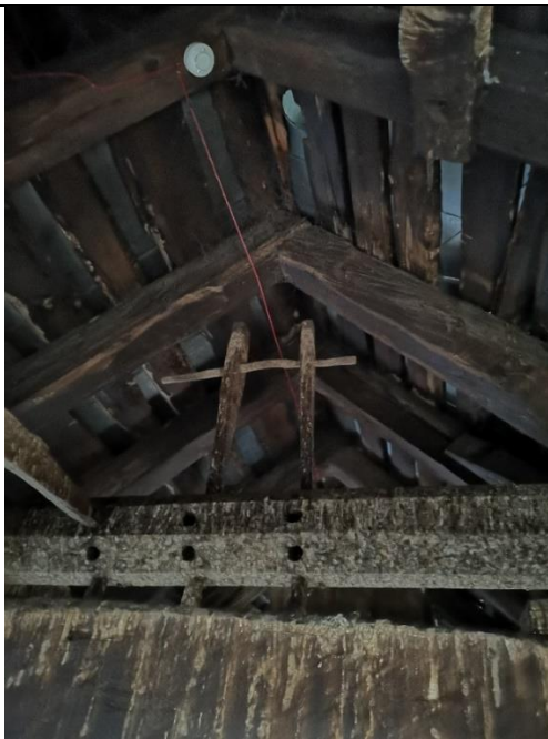
13. attēls. Koka spāru balstījums korē (stāvoklis labs);
