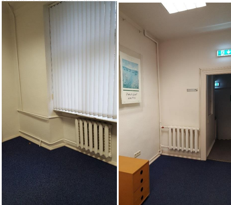
51.attēls. Čuguna radiatori bez termoregulatoriem
