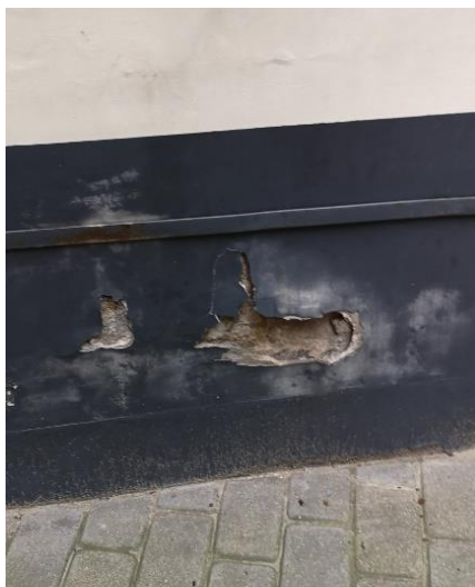
32.attēls. Ārējās apdares apmetuma bojājums
