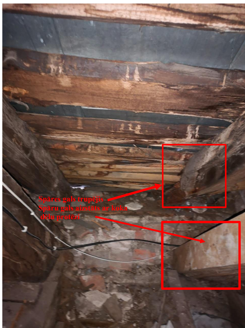
14. attēls Koka jumti. Spāru balstvietas (nesošā konstrukcija)
