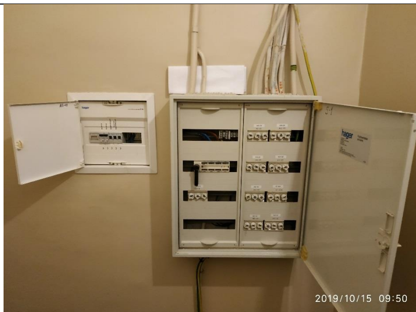
60.attēls. Ēkas galvenā un grupu sadalne.
