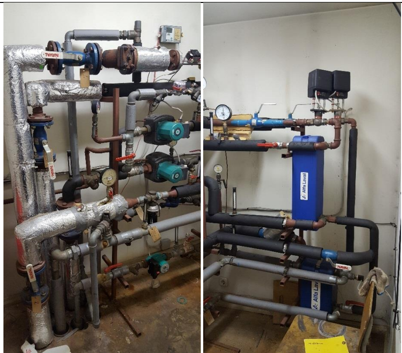
48.attēls. Siltummezgls 1.stāvā 48.a.attēls. Apkures un karstā ūdens siltummaiņi
