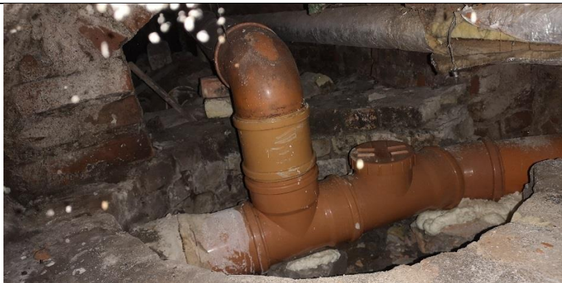
38.attēls. Kanalizācijas aka pagrabstāvā..
