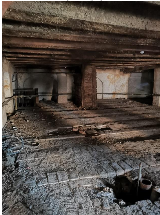
11.b. attēls. ķieģeļu mūra virssegums (redzamas deformācijas).
