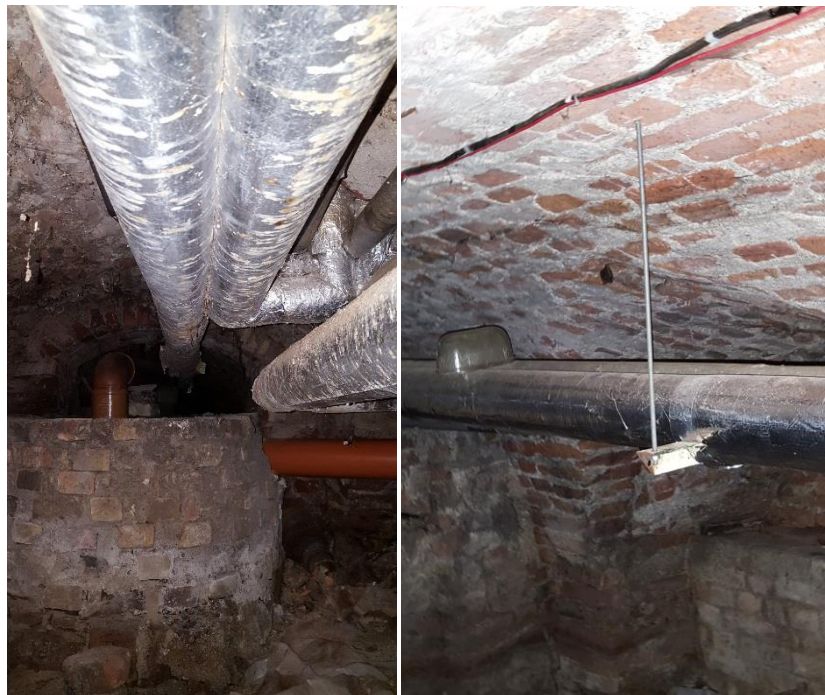
49.attēls. Apkures cauruļvadu trasējums pagrabā
